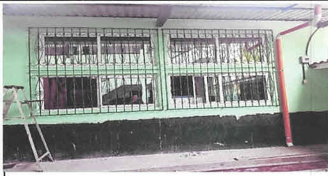
Mantenimiento, lijado y pintura a balcones.
