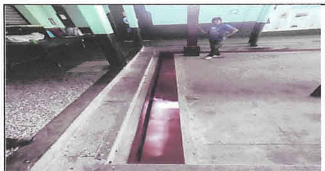
Mantenimiento a rejilla de alcantarillado
